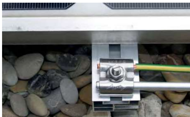
Obrázek 9.18.3 Zemnicí svorka UNI: mezičlen z korozivzdorné oceli zabráňuje kontaktní korozi. Tím jsou vytvořena dlouholetá spolehlivá propojení mezi různými materiály vodičů.
