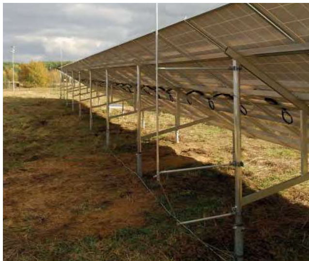
Obrázek 9.19.2 Hromosvod s držáky DEHNiso
