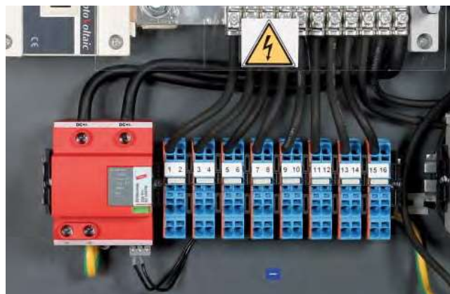
Obrázek 9.19.11 Přepětová ochrana v rozvaděči připojení FV generátoru s monitoringem stringů
